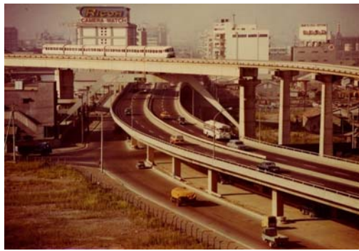
首都高速一号羽田線 1964年完成
