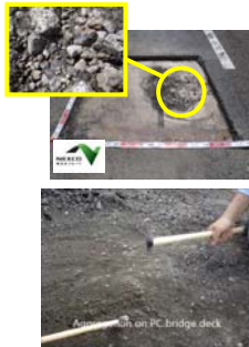
疲労荷重と浸水の複合でコンクリートが砂利化!
