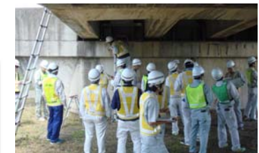
現地実習状況 (H28橋梁初級Ⅰ)
