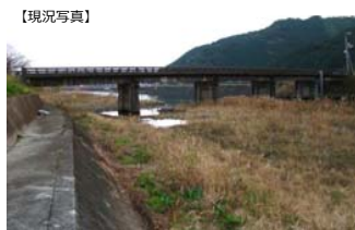
▲下ノ加江橋（供用から58年経過）
