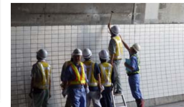
現地実習状況 (H28トンネル初級)
