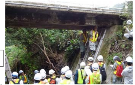
橋梁点検フィールドワーク
