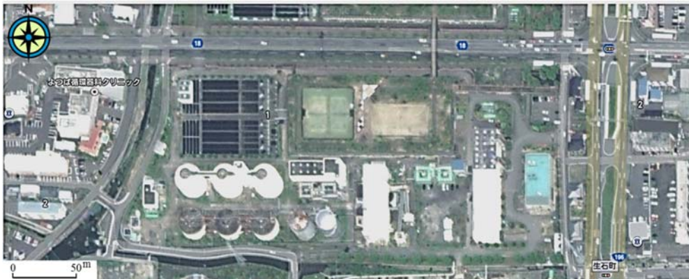
図1 松山市下水道中央浄化センター (Google から)
