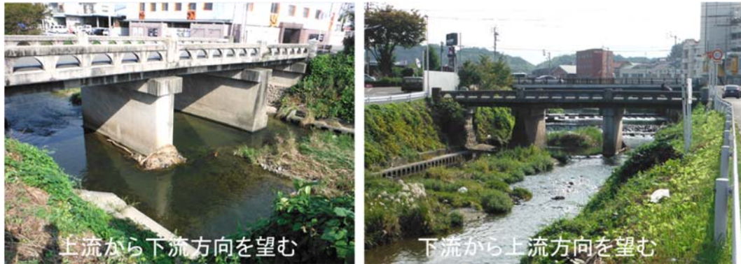
図 2 天山橋全景（左：上流から、右：下流から）
