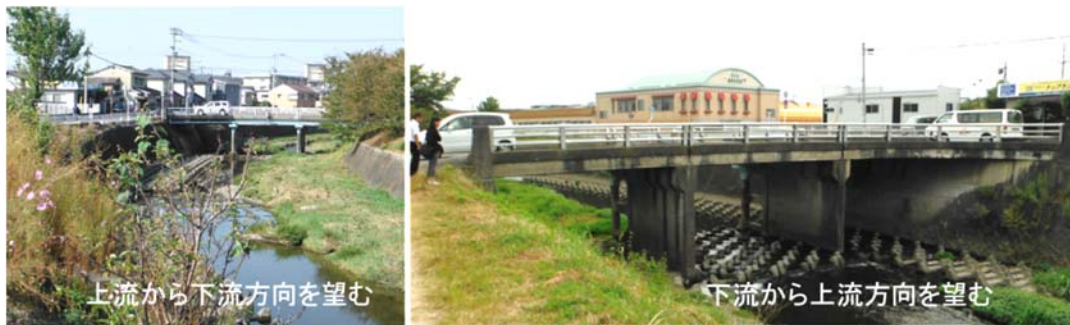
図 3 星岡橋 (左：上流側から全景を望む. 右：下流側から全景を望む)
