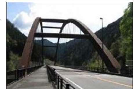
不動橋の全景
