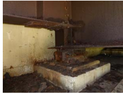
支承 (支承は塗装仕様)
