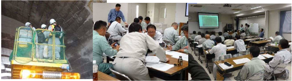
③④⑤ トンネル近接目視
