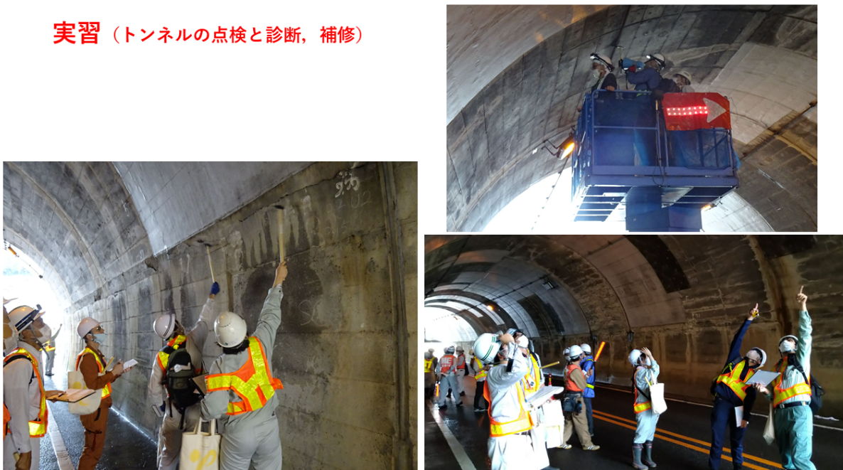
写真 3-7 フィールド実習（トンネル）の状況
