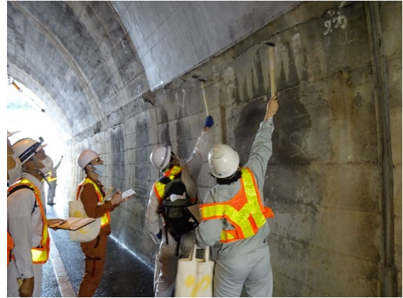
トンネルの点検と診断，補修(砥鹿山隧道)
