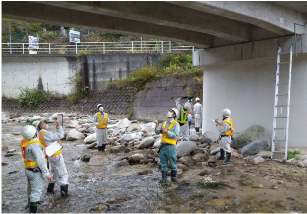
橋梁の点検と診断，補修（河中橋）
