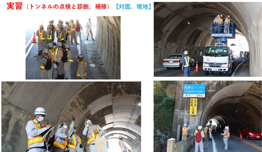
写真 3-7 フィールド実習（トンネル）の状況
