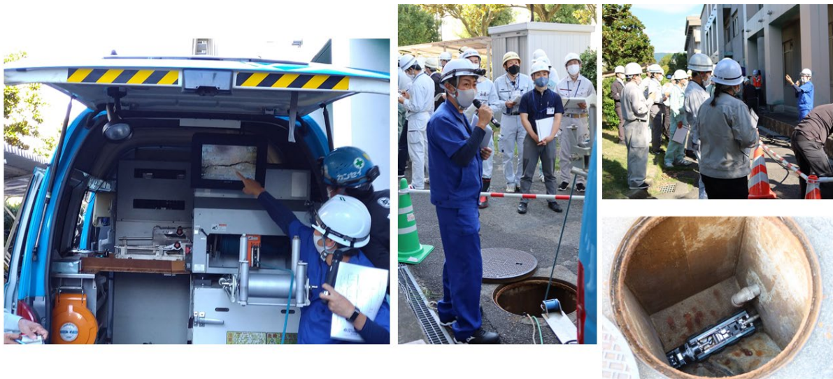
写真 3-4 フィールド実習の状況（下水道）
