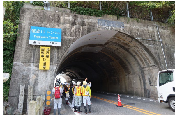
トンネル（砥鹿山隧道）
