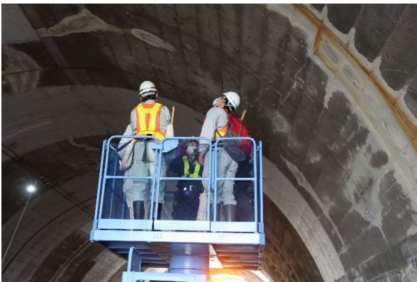
トンネル（砥鹿山隧道）
