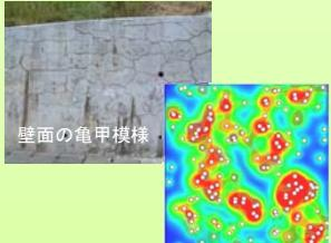
アルカリシリカ反応(ASR)による骨材膨張と、骨材膨張に伴うひび割れをモデル化する。ASRはアルカリイオンの非定常拡散解析、ひび割れは損傷モデルを導入した非線形有限要素解析によって行い、これらを分離型時差解法によって連成している。左図に示すようなコンクリート壁の亀甲を表現するために、数千万ボクセル規模の解析を予定している。
