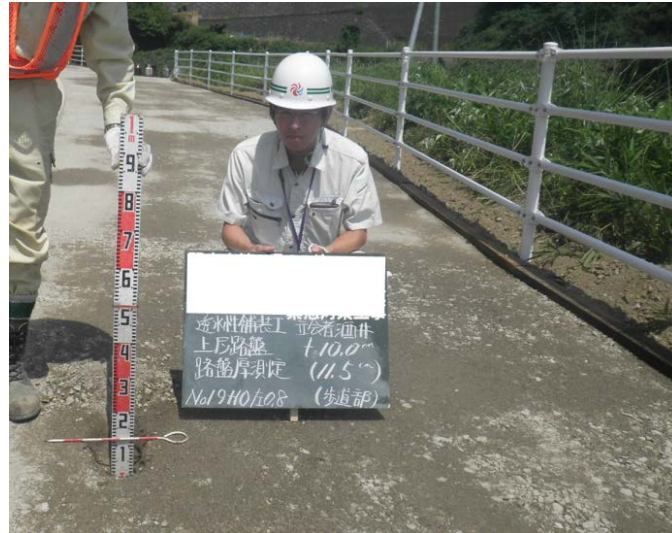
写真-1 現場確認の様子（1）
