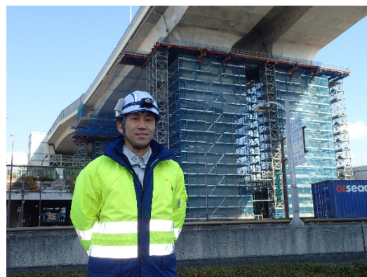
担当する橋梁補修工事の現場
