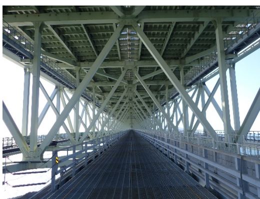
明石海峡大橋内部の維持管理用通路
