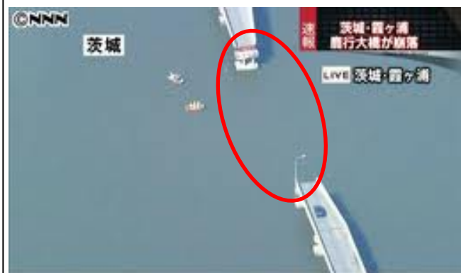
写真2 鹿行大橋崩落事故(航空写真) 橋梁の中央部分(赤丸部分)が崩落。
