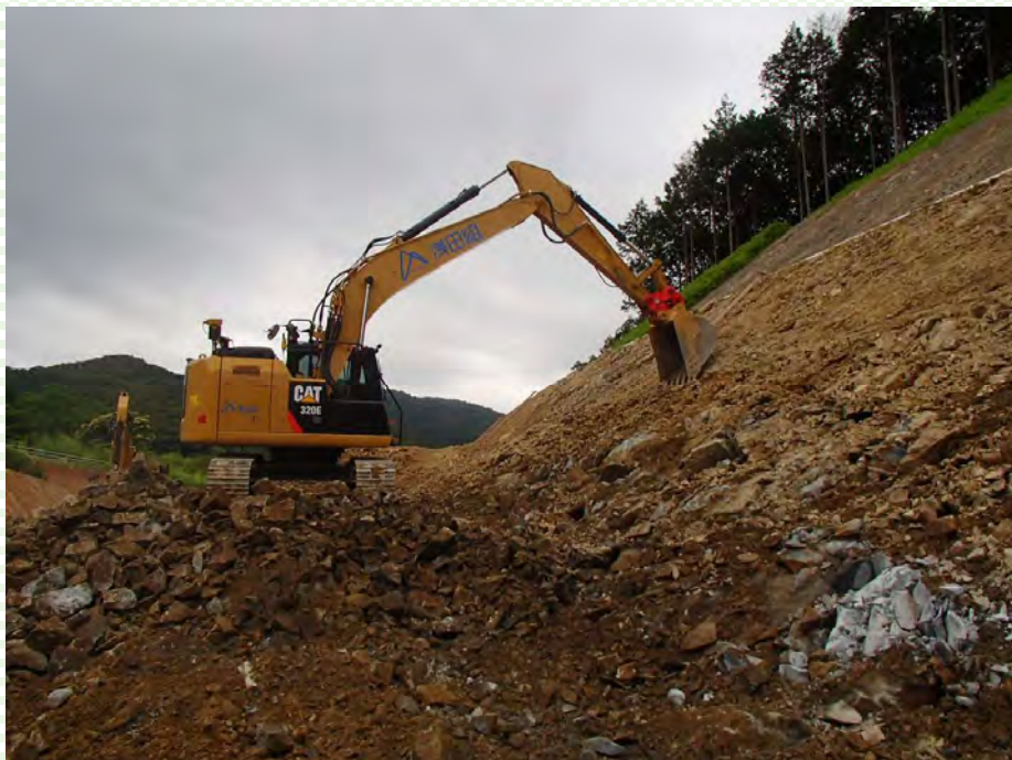
平成27-28年度増田改良工事
