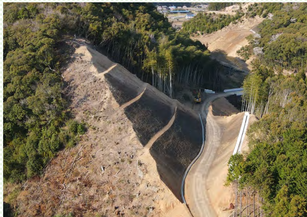
令和2年度津島道路上畑地地区工事用道路工事
