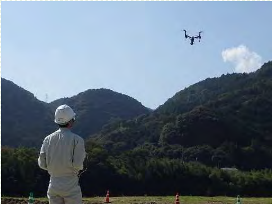
令和2年度肱川河道掘削工事
