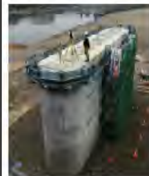
従来施工 (高所での測量)
