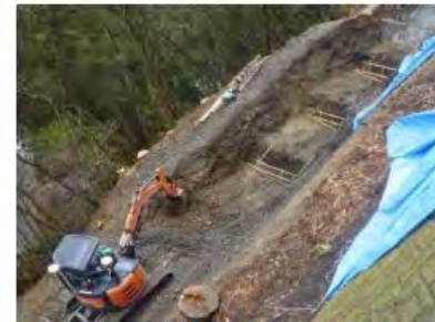
ICT建機による掘削作業
