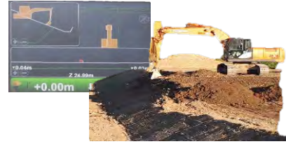
③ ICT建機に よる施工
